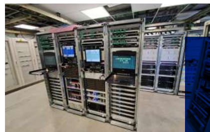
Cometa. Instalación de un sistema de comunicaciones tierra-aire de última generación para la renovación de los sistemas de control de tráfico aéreo del aeropuerto.
